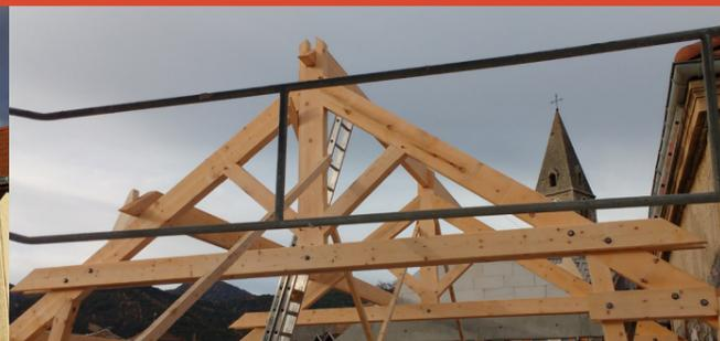
Cette première phase de 2017 consiste essentiellement à réaliser des travaux sur la structure, à savoir **rehausser les 2 ailes Nord et Sud du bâtiment afin de gagner des surfaces supplémentaires.** Pour ceci, les toitures sont démontées puis remontées, et des planchers doivent être repris ou créés.
